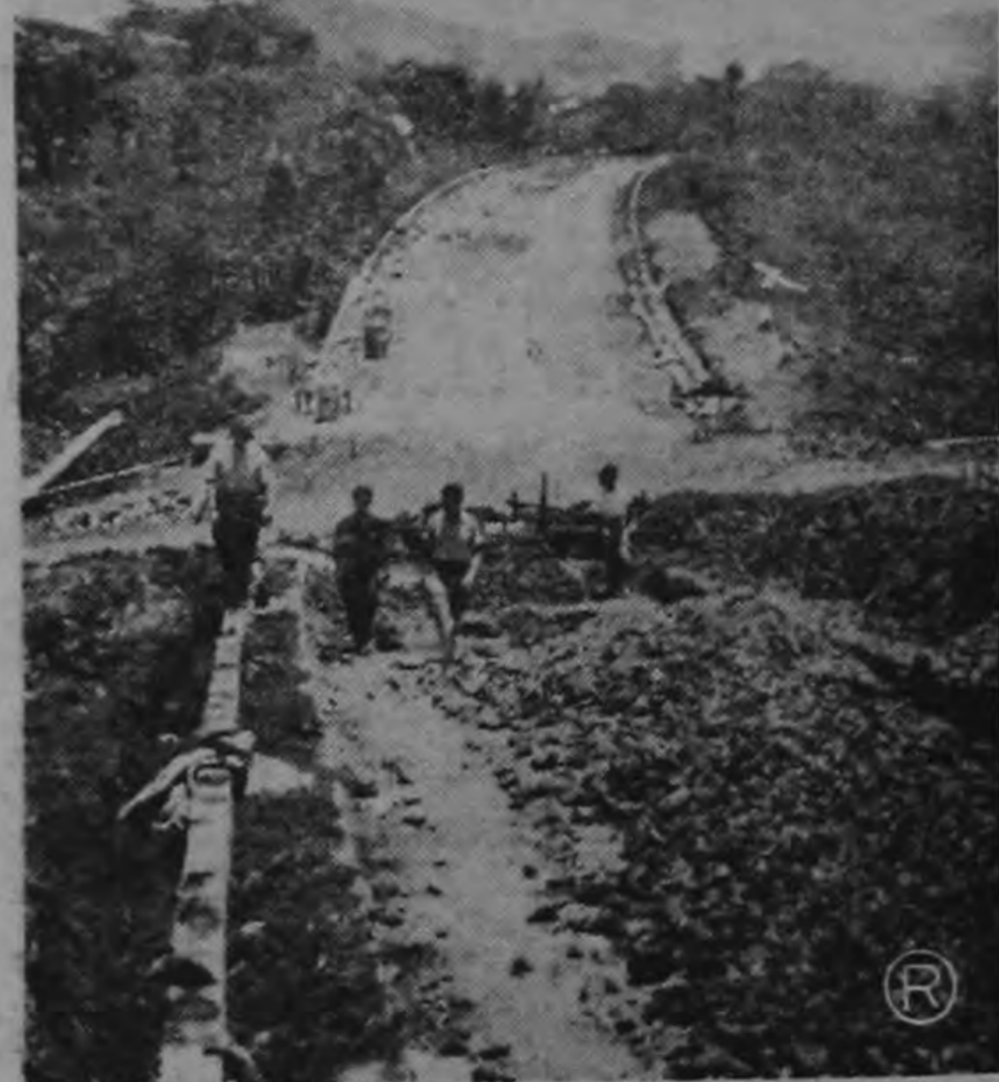
INSPECCION DE UNIDAD VECINAL.—La fotografía recoge el momento en que el Sr. Gerente del Invú, Lic. Rodrigo Carazo y altos personeros del mismo, llevan a cabo una inspección ocular de las obras de urbanización que se efectúan en la Unidad Vecinal de Hatillo, en San José.
